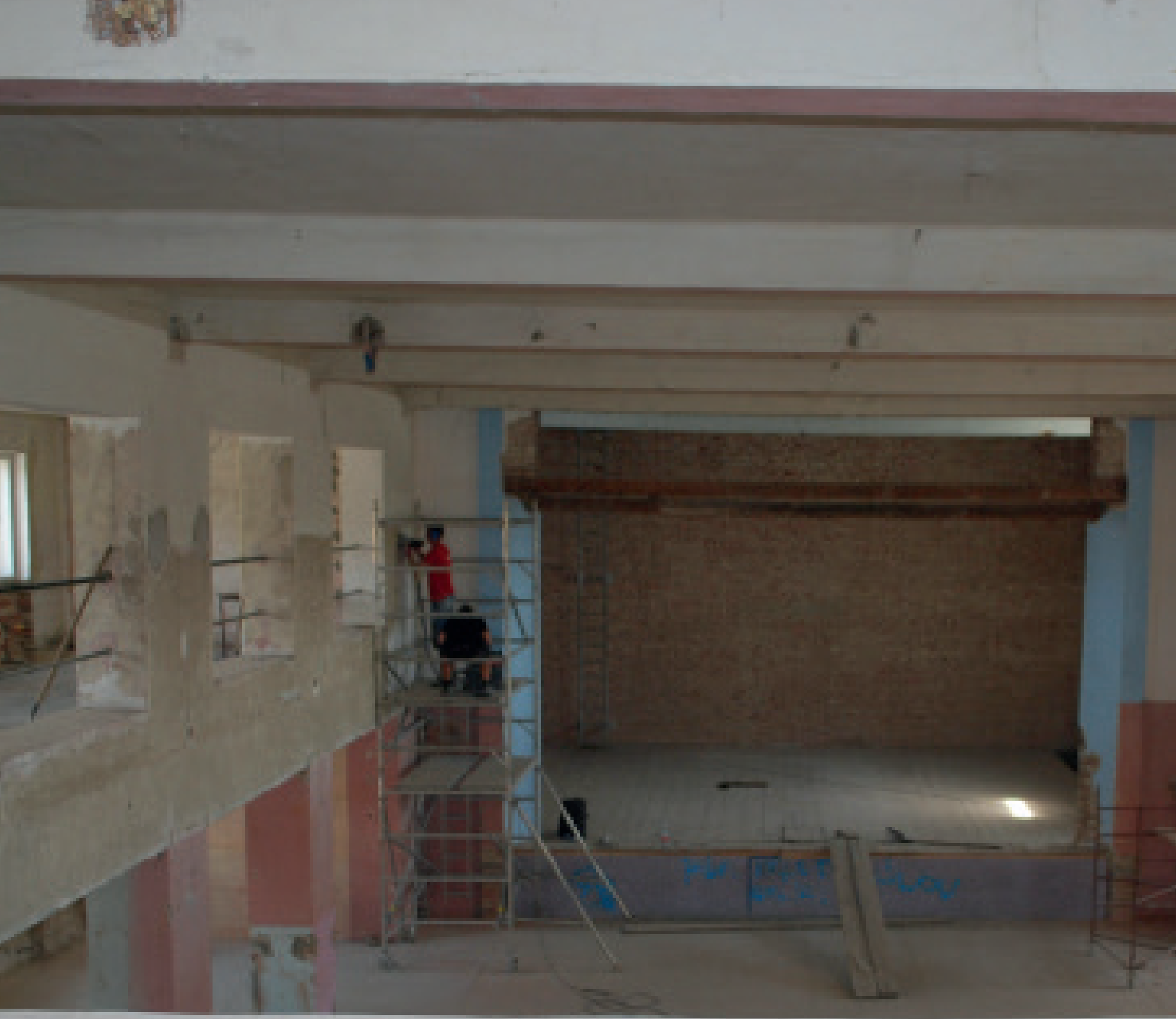
Rekonstrukce hlavního sálu včetně jeviště
