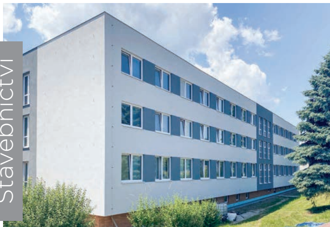
Control Invest projekt, s.r.o Bzenec – zateplení objektu
