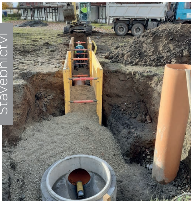
Pasohlávky – rekonstrukce kanalizace
