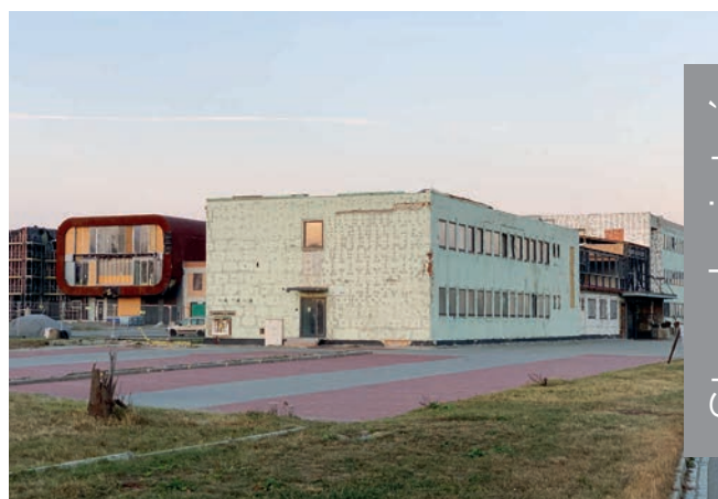
Rekonstrukce areálu MND v Lužicích
